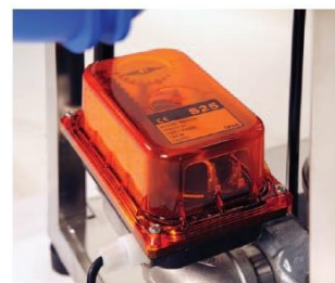
Сервопривод завдвижки
