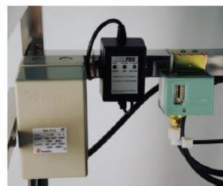
Блок управления задвижкой
